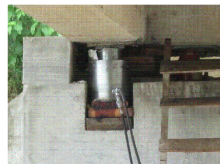
NICHOS DE IZAJE PARA COLOCACION DE GATO HIDRAULICO PARA CAMBIO DE PLACAS DE NEOPRENO
